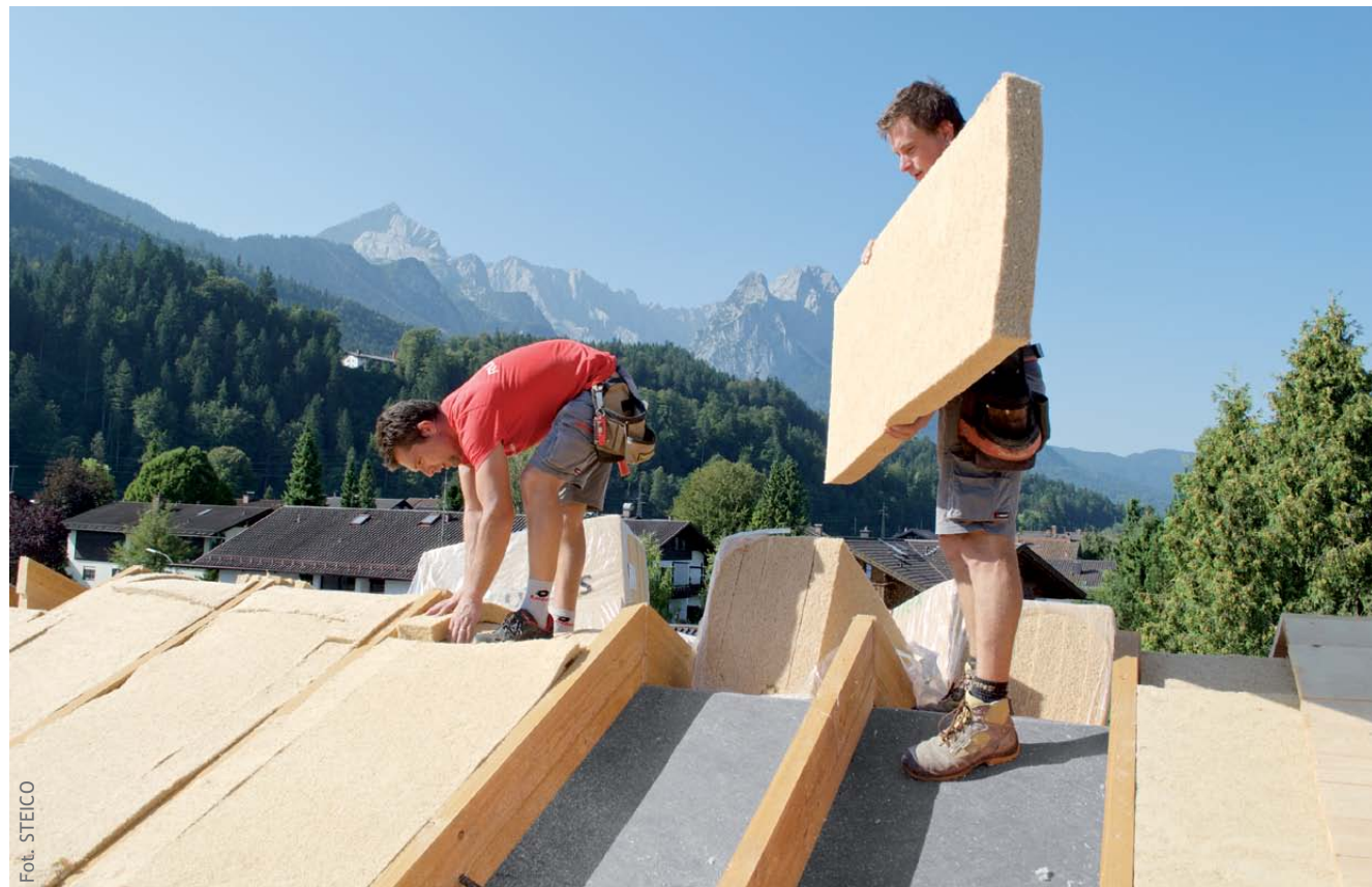
Fot. STEICO Sprężysta mata z włókien drzewnych STEICOflex doskonale izoluje termicznie przegrody budynku, ponieważ ma dużą gęstość a jednocześnie wysoką zdolność do akumulacji ciepła.
